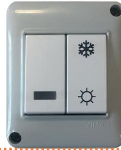
Il comando base a 2 tasti OCTR000 segnala lo stato di blocco fiamma e ne permette il reset. In aggiunta permette di selezionare la modalità di ventilazione estiva.
